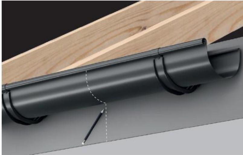
Platzieren Sie nach dem Anbringen der Haken die Dachrinne und markieren Sie die Position des Stutzens am tiefsten Punkt der Dachrinne.
