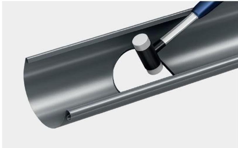
Mit geeigneten Werkzeugen, die die Dachrinnenbeschichtung nicht beschädigen, z. B. Gummihammer, profilieren wir die Schnittkante von der Innenseite der Dachrinne aus.
